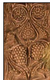
آرایه‌ی گچ‌بری حلزونی با روش مشبک (مطبق)، زیر قوس پیش تاق برج کاشانه‌ی بسطام، (ولی، ۱۴۰۲)
