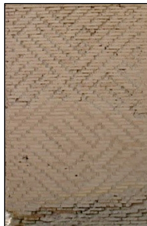
شکل ۲۱. کتیبه با خط بنایی شامل تلفیق آجر و توبی‌های ته‌آجری در ایوان جنوبی جامع هفتشویه (رازانی و حیدری باباکمال، ۱۳۹۹: ۶۷)
