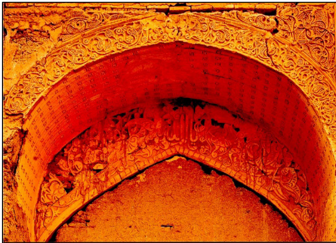
شکل ۲۷. طاق نمای ضلع غربی گنبدخانه‌ی مسجد هفتشویه (موحدی، ۱۴۰۰: ۹۱) Figure 27. Arch of the western side of the dome chamber of Haftshoyeh Mosque (Movahedi, 2021: 91)
